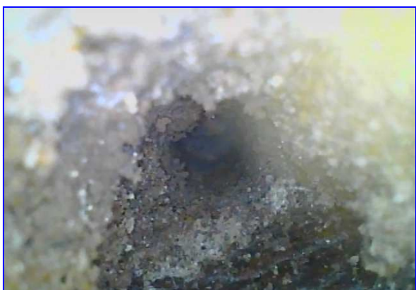
E5 - 1 Muratura in pietra con cavità in corrispondenza del giunto di malta
