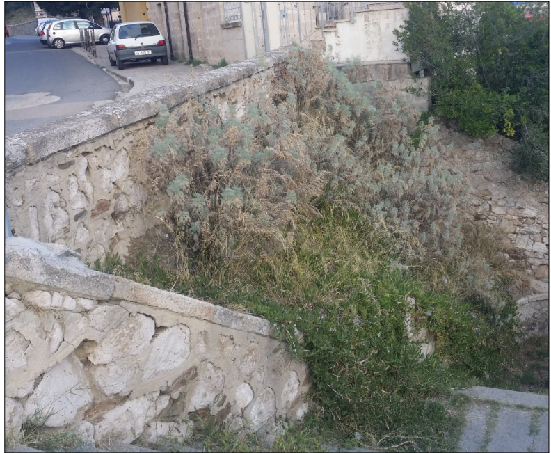
FIGURA 21 - A sinistra: evidente disallineamento del parapetto del muro. A destra: la scalinata di accesso all'area parcheggio dell'ARST. Sotto la vegetazione erbacea è stata rinvenuta una parete rocciosa conformata con angolo di circa 80°. La roccia è scistosa, polideformata e molto fratturata.
