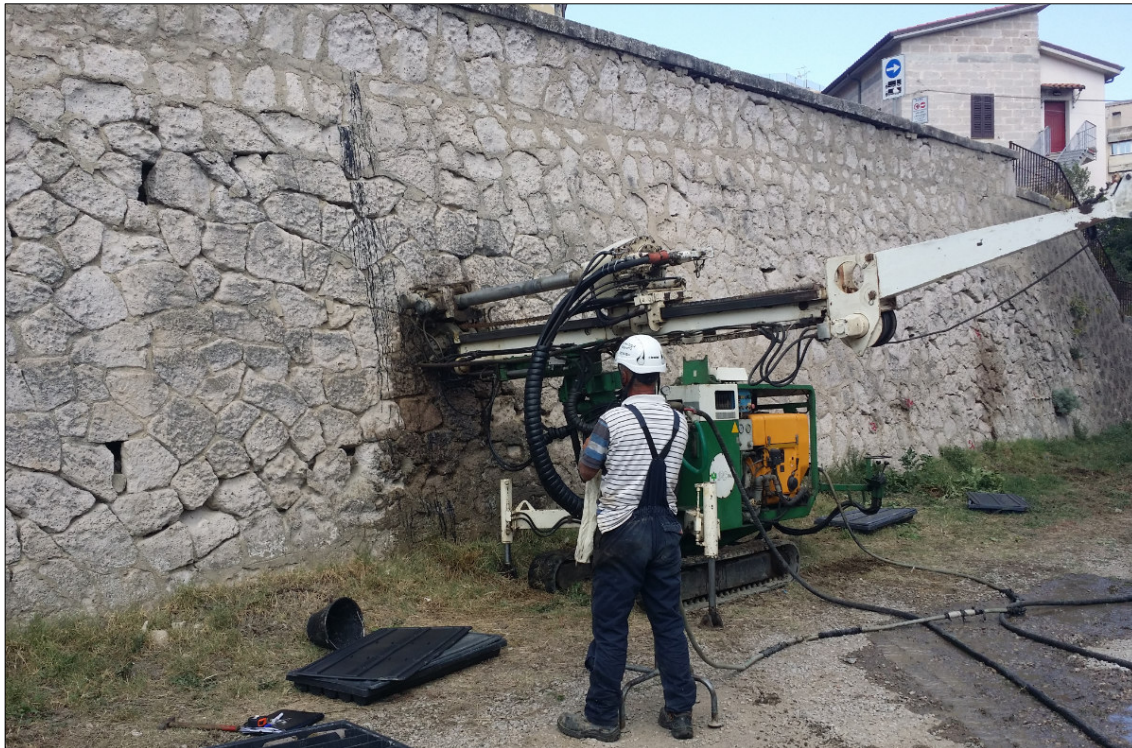
FIGURA 19 - Posizionamento sondaggio S8, orizzontale. Il foro è stato effettuato a +2.20 m dal p.c.
