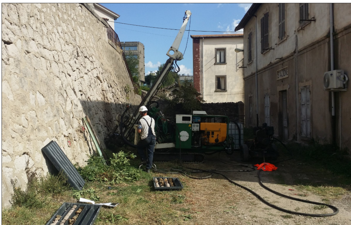
FIGURA 17 - Posizionamento sondaggio S6, inclinato di 70° rispetto al piano campagna
