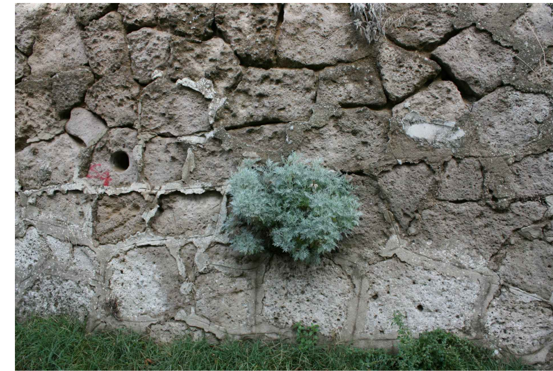
Foto 5. Dettaglio presenza di vegetazione superiore della muratura ed esiti dei carottaggi
