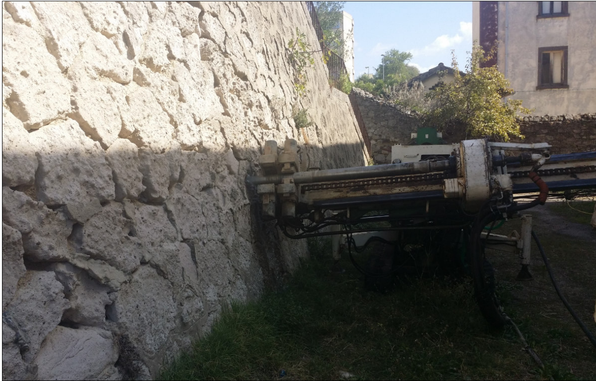
FIGURA 14 - Posizionamento sondaggio S4, orizzontale. Il foro è stato effettuato a +1.20 m dal p.c.
