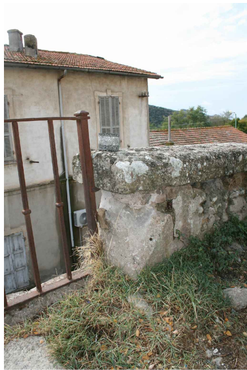
Foto 1. Erosione pietra del paramento sull'attacco muro-scala
