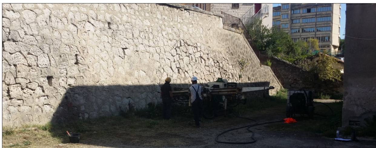
FIGURA 13 - Posizionamento sondaggi S3 e S3bis, entrambi orizzontali.
