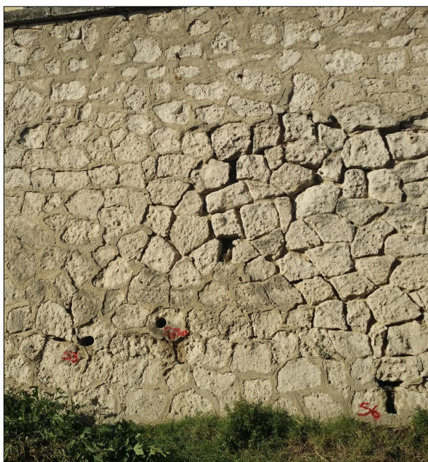
FIGURA 20 - Individuazione dei fori di sondaggio nella muratura
