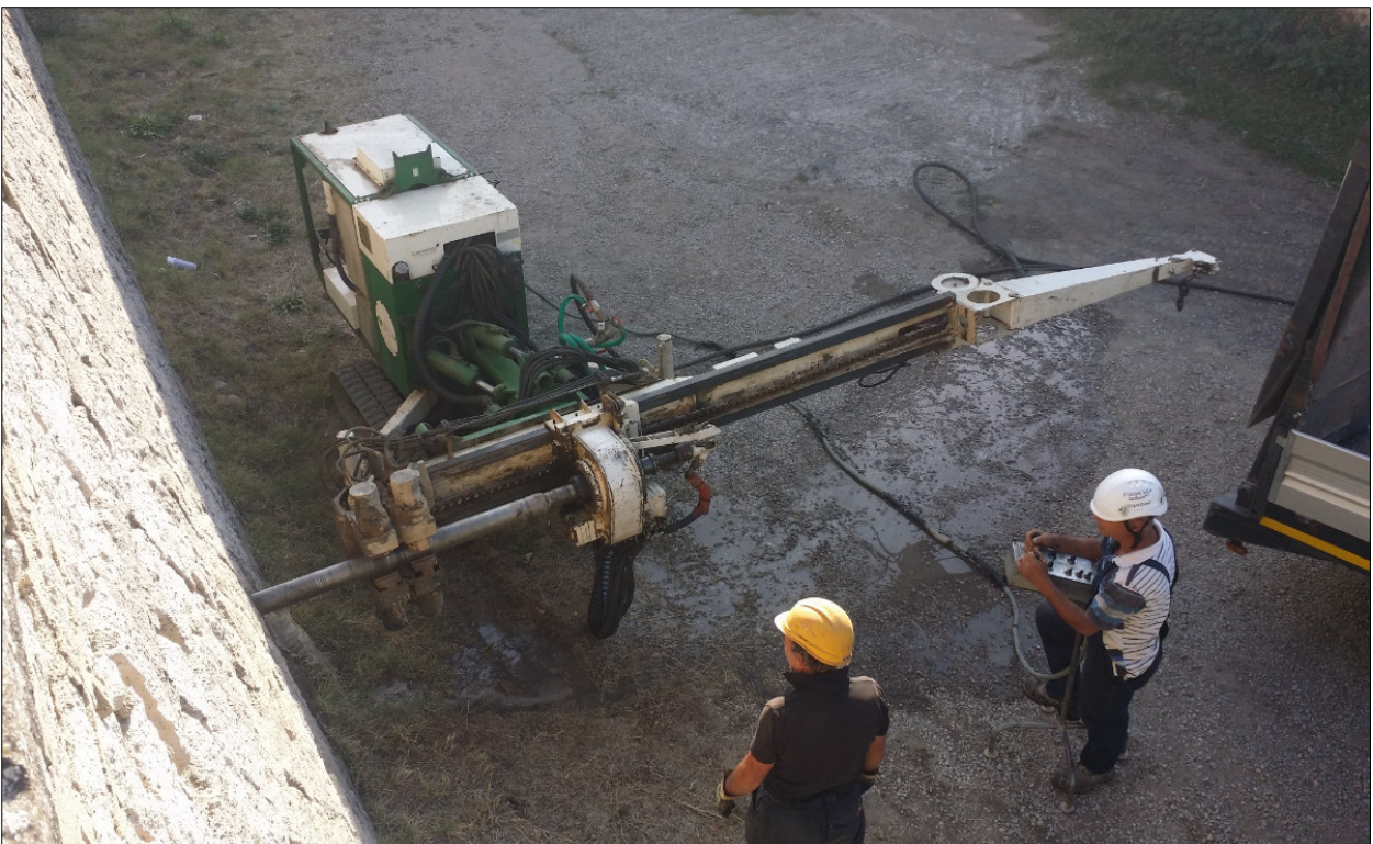
FIGURA 12 - Posizionamento sondaggio S2, orizzontale. Il foro è stato effettuato a +1.0 m dal p.c.
