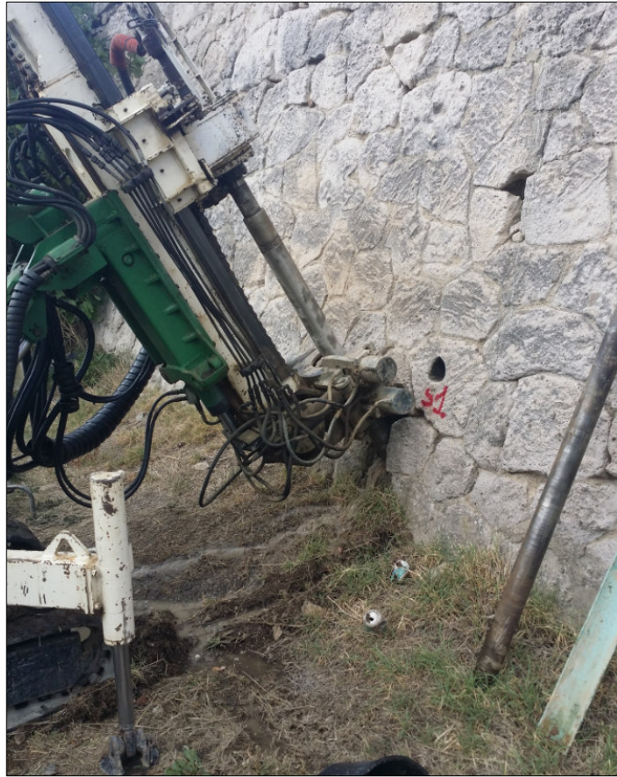
FIGURA 18 - Posizionamento sondaggio S7, inclinato di 70°. Il foro è stato effettuato a +0.4 m dal p.c.
