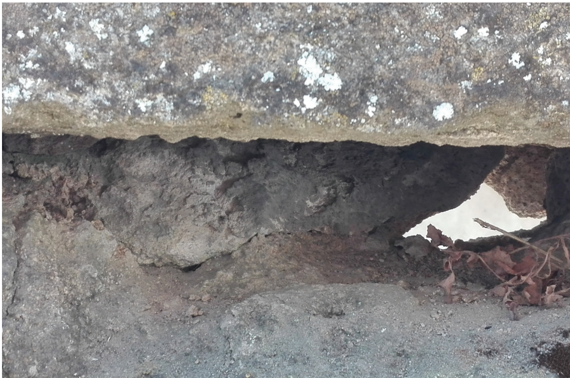
Foto 18 Dettaglio della sconnessione traparapetto e coperina a livello stradale.
