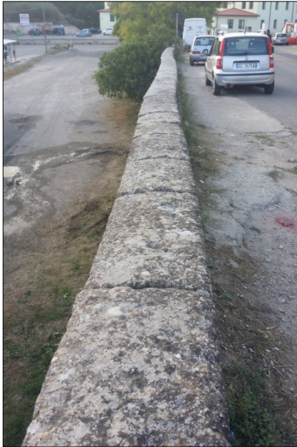
FIGURA 21 - A sinistra: evidente disallineamento del parapetto del muro. A destra: la scalinata di accesso all'area parcheggio dell'ARST. Sotto la vegetazione erbacea è stata rinvenuta una parete rocciosa conformata con angolo di circa 80°. La roccia è scistosa, polideformata e molto fratturata.
