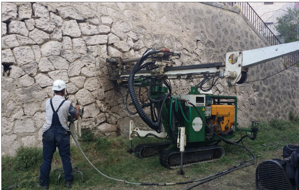
FIGURA 16 - Posizionamento sondaggio S5, orizzontale. Il foro è stato effettuato a +2.30 m dal p.c. L'immagine mostra anche l'entità dell'alterazione dei conci di "trachite" e la perdita della malta tra di essi a base di calce
