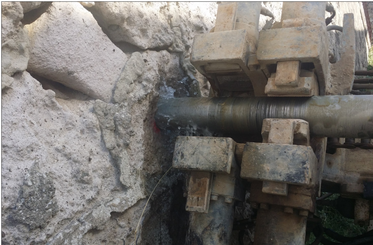
FIGURA 15 - Sondaggio S4. Per facilitare la perforazione e raffreddare la corona diamantata è stato necessario un importante consumo d'acqua.
