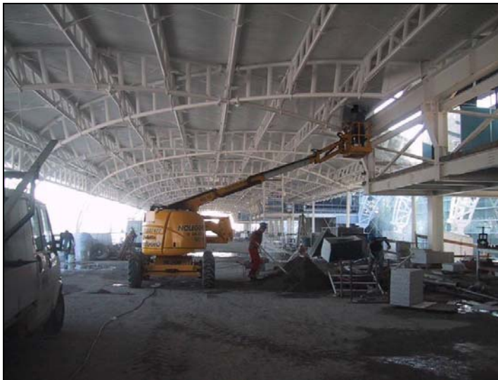
Lavori con l'uso della piattaforma elevatrice
