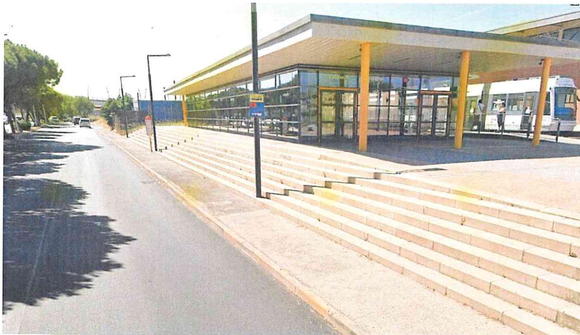
Fermata ARST via San Gottardo lato fermata metro S.Gottardo (fig.17).
