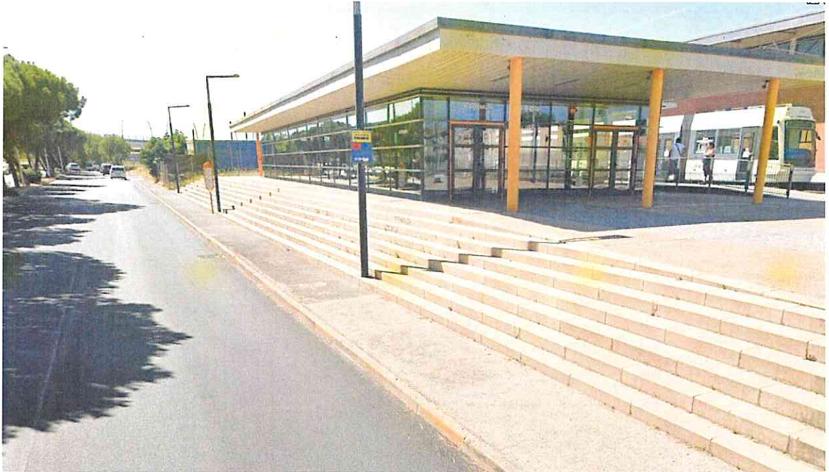
Fermata ARST via San Gottardo lato fermata metro S.Gottardo (fig.3)
