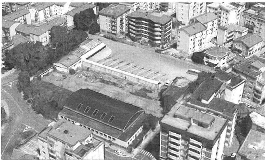
Il complesso immobiliare oggetto di stima (fonte Google Earth)
