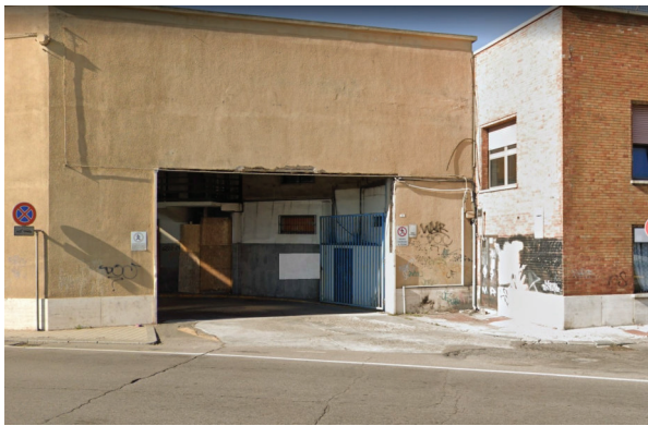
- ripristino architrave in cls varco uscita autobus
