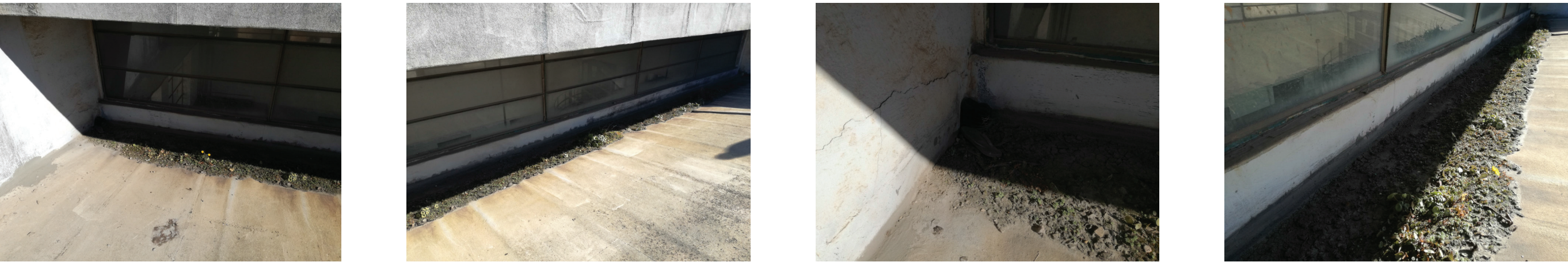
2 - pulizia solaio da materiale vegetale/terroso (per una estensione di circa 65 m x 0,40 m)
