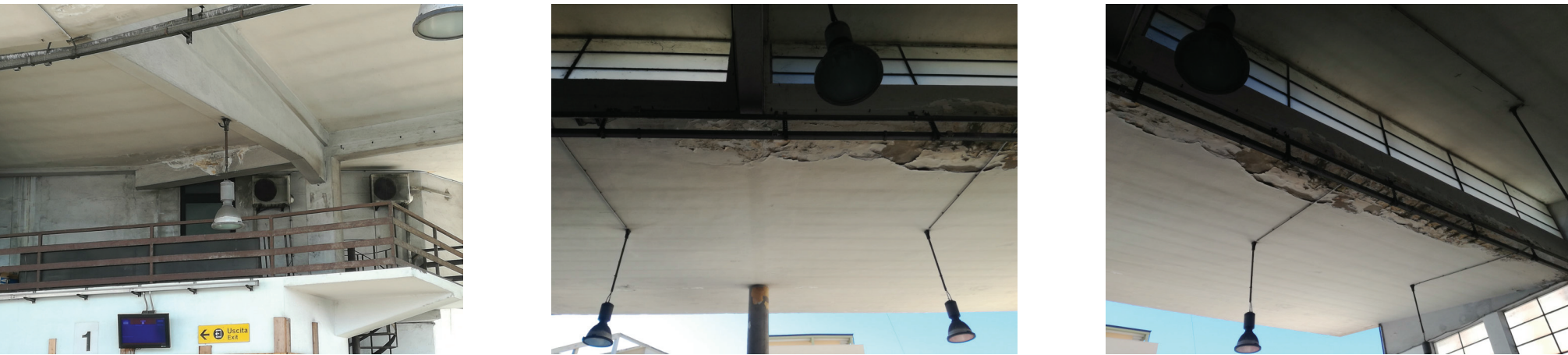
3 - ripristino intonaci estradosso solaio
