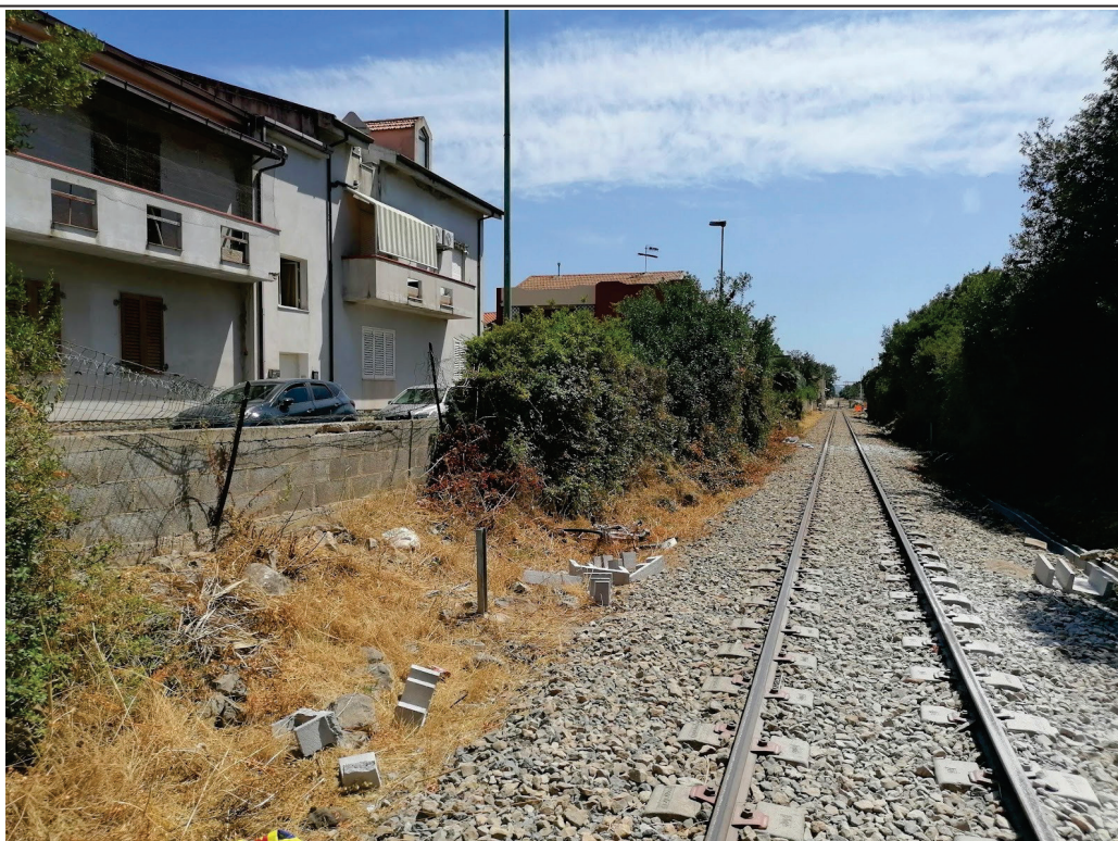
Immagine 02 – esempio di tratto interessato dal ripristino di recinzione metallica su muretti in blocchetti
